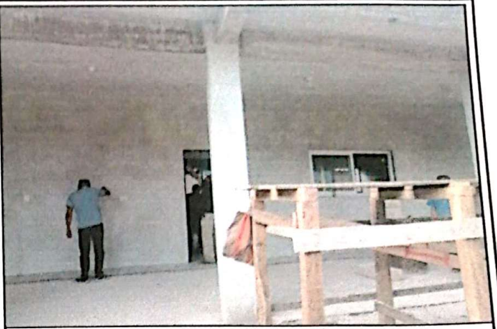
Foto 2: Reparación de repello y cernido de paredes
