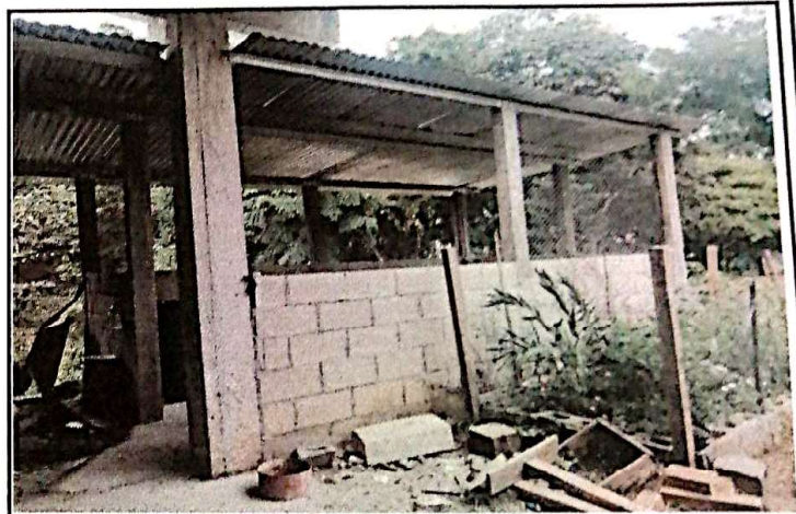
Foto 4: Reparación o sustitución de área de cocina
