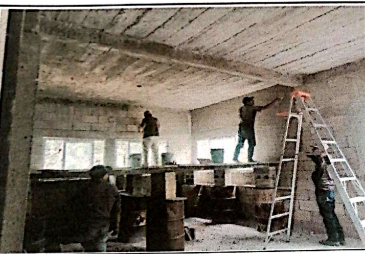
Foto 3: Reparación de repello y cernido de paredes
