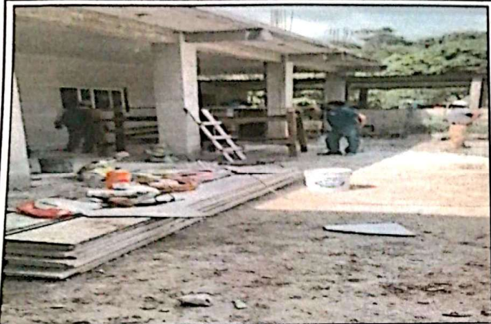
Foto 1: Reparación de repello y cernido de paredes
