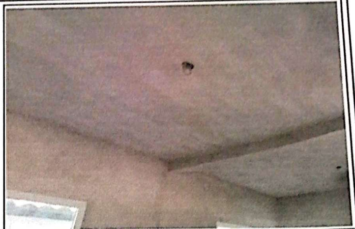
Foto 2: Reparación de sistema eléctrico
